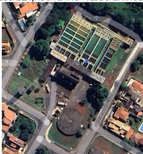
FIGURA 77: LOCALIZAÇÃO DA ETA DA SEDE URBANA DE MOGI GUAÇU
