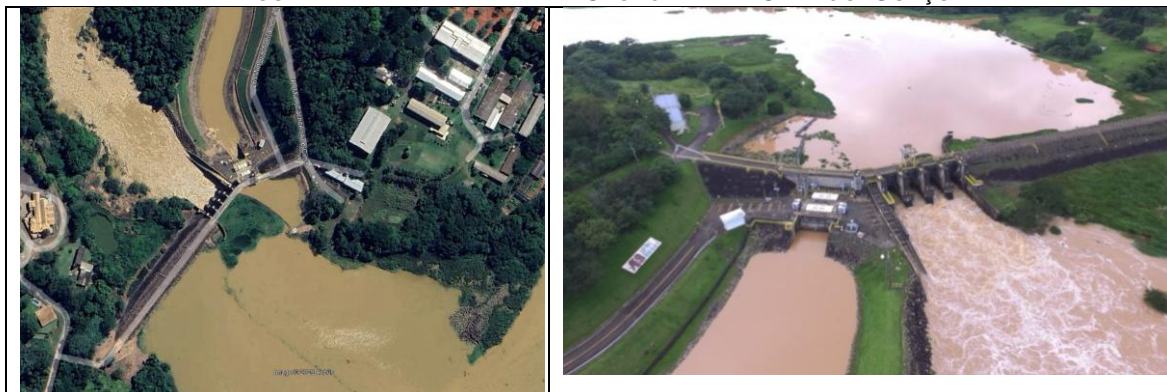
FIGURA 27: VISTA DA REPRESA CACHOEIRA – PCH MOGI GUAÇU
