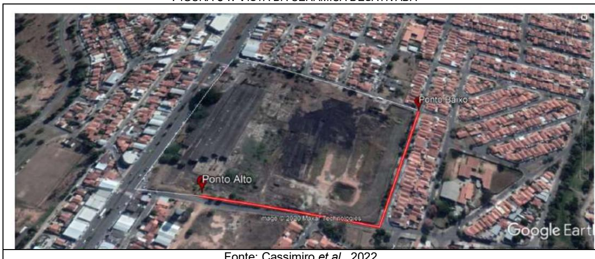
FIGURA 64: VISTA DA CERÂMICA DESATIVADA
